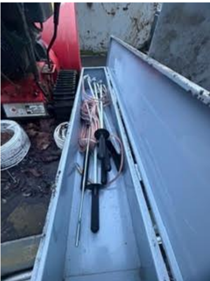
Messa a terra BT
